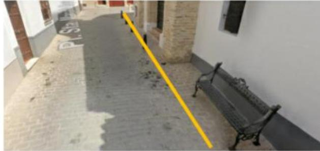
**2. SEÑALIZAR CL. TOLEDANO, Nº 16.** Pintar línea amarilla longitudinal continua sobre la calzada a partir del número 16 y hasta la esquina, conforme a la fotografía adjunta. Instalar señal vertical R-308 con la reseña (6mt).
