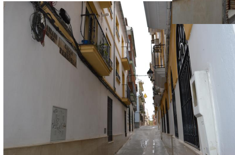
Viviendas unifamiliares y plurifamiliares en Andovalas
