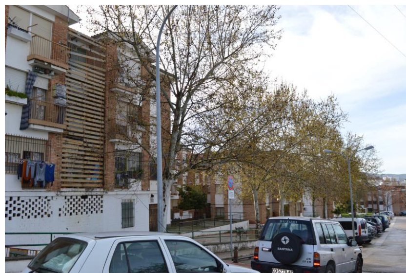
Viviendas sociales plurifamiliares en Belén
