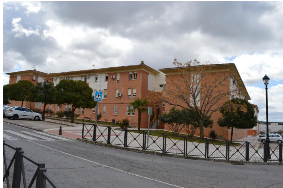
Viviendas Públicas Sociales en Aradillo y Belén respectivamente
